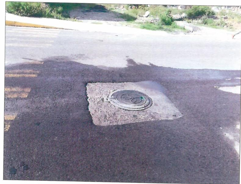
SE CONSTATÓ DEFICIENCIAS TÉCNICAS CONSTRUCTIVAS EN LA RENIVELACIÓN DE POZOS DE VISTA, UBICADOS ENTRE LOS CADENAMIENTOS 0+120 AL 0+200.
