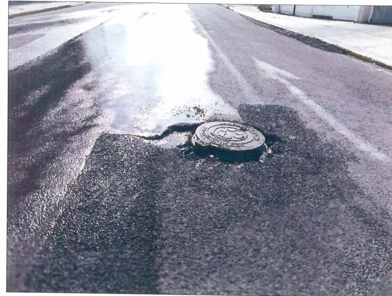
SE CONSTATÓ DEFICIENCIAS TÉCNICAS CONSTRUCTIVAS EN LA RENIVELACIÓN DE POZOS DE VISTA, UBICADOS ENTRE LOS CADENAMIENTOS 0+120 AL 0+200.
