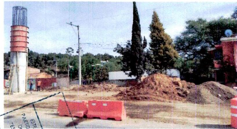
Obstrucción en la construcción de la rama 30, debido a la presencia de las líneas aéreas de baja y media tensión. Por este problema no se pueden ejecutar las estructuras del proyecto 1a, 1b, 1c, 1d y 1.
